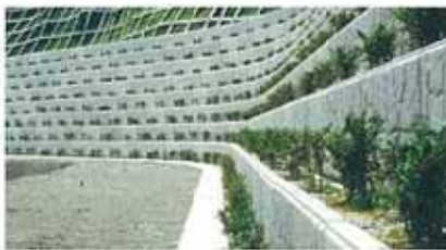
運動公園の全段緑化の鳥尻泥岩間切土擁壁
