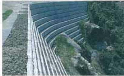
基礎の岩場部を残した縦断施工の盛土擁壁
