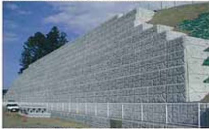
市民公園際の道路拡幅の切土擁壁
