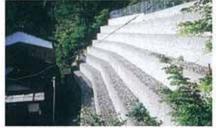
住宅裏の箱型擁壁
