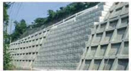
アンカー工法壁の復旧
