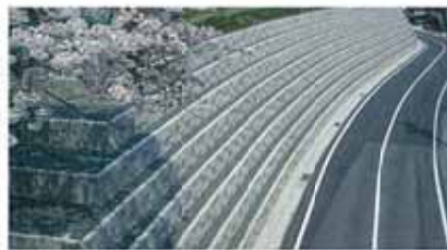
市街地の切土擁壁
