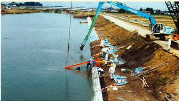
工事名：福島潟放水路西水路 施主：新潟県新潟土木事務所
