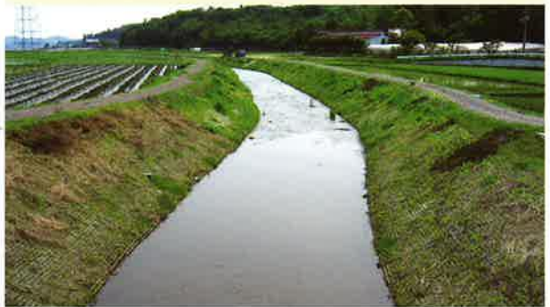
工事名：国庫補助河川災害復旧助成工事（小貝川） 施主：栃木真岡土木事務所
