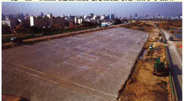
工事名：城北地区耐震対策緩傾斜地盤改良（その3工事） 施主：国土交通省近畿地方整備局淀川工事事務所
