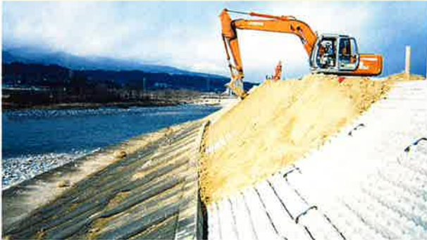
工事名：天竜川伊久間築堤工事 施主：建設省中部地方建設局（現：国土交通省中部地方整備局）天竜川上流工事事務所
