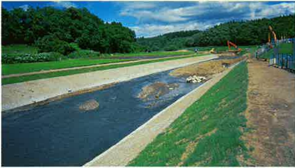
工事名：後藤川災害復旧助成工事 施主：青森県十和田土木事務所
