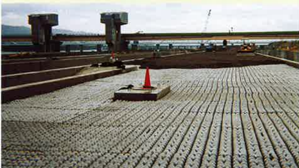
工事名：紀ノ川大堰高水敷保護工事 施主：国土交通省近畿地方整備局和歌山工事事務所
