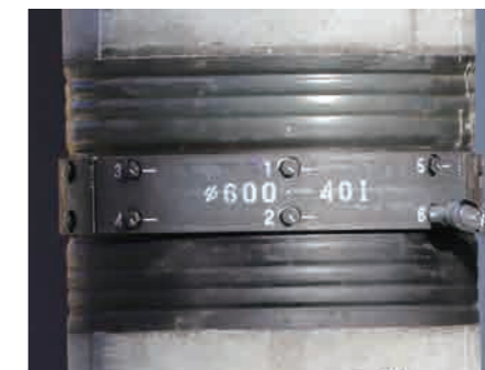
本締め完了後、ボルト頭部とプレートのマーキングのズレを確認する。
