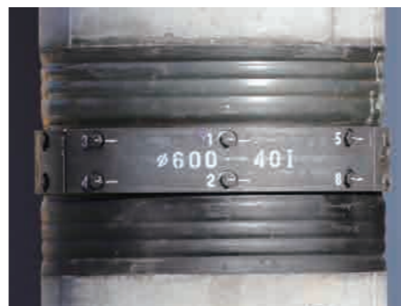
一次締め完了後、ボルト頭部からプレートにかけて一本線でマーキングする。
