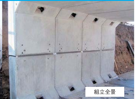
グラウト注入後
