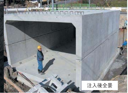
グラウト注入
